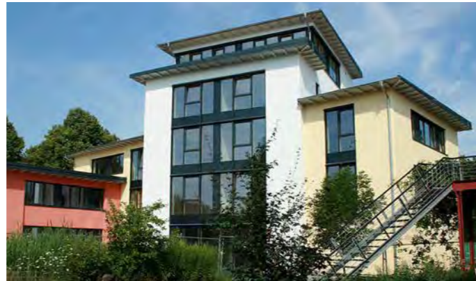
Kompetenzzentrum für Nachhaltiges Bauen in Verden, als direktverputzter strohballgedämmter Holzbau mit 5 Etagen in seiner Art der höchste in Europa
