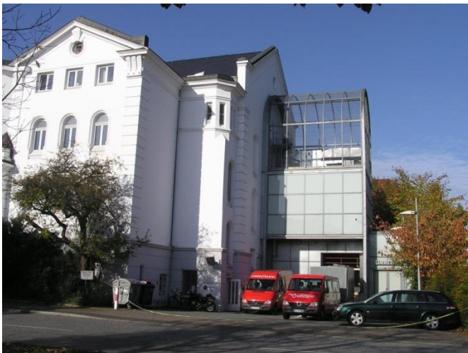
Bild 8: Stadttheater Rendsburg – Ecksituation Teilbereich Süd-Ost-Fassade und Nord-Ost-Fassade mit Bühneneingangsbereich -
