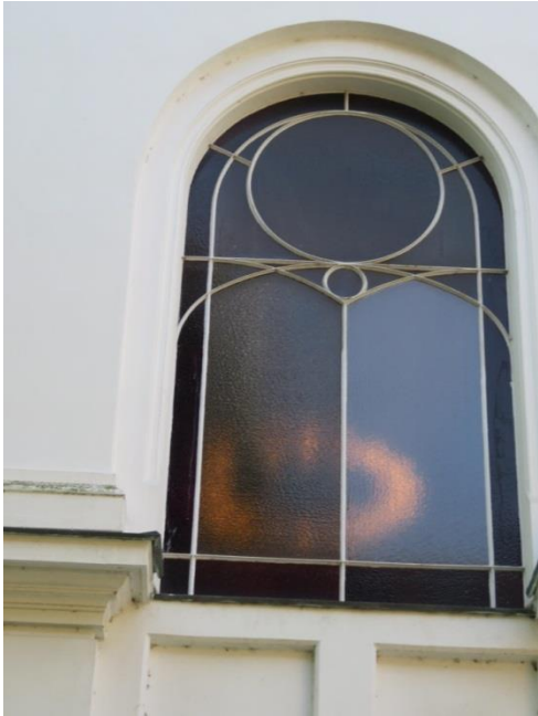
Bild 5: Stadttheater Rendsburg – Treppenhausfenster mit der Größe ca. B x H = 1,90 x 3,00 m
