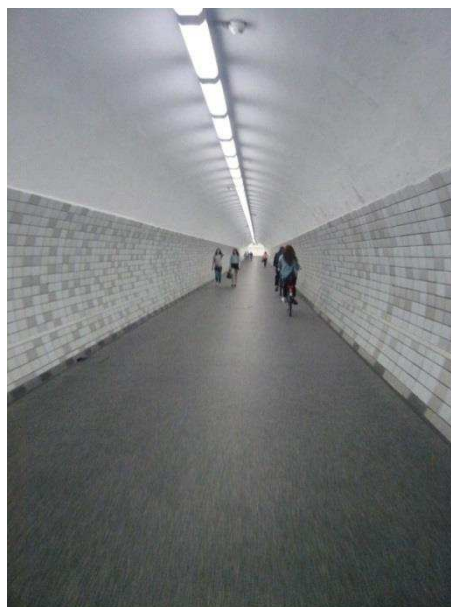
Abbildung 35: Fuß- und Radtunnel Quelle: eigenes Foto
